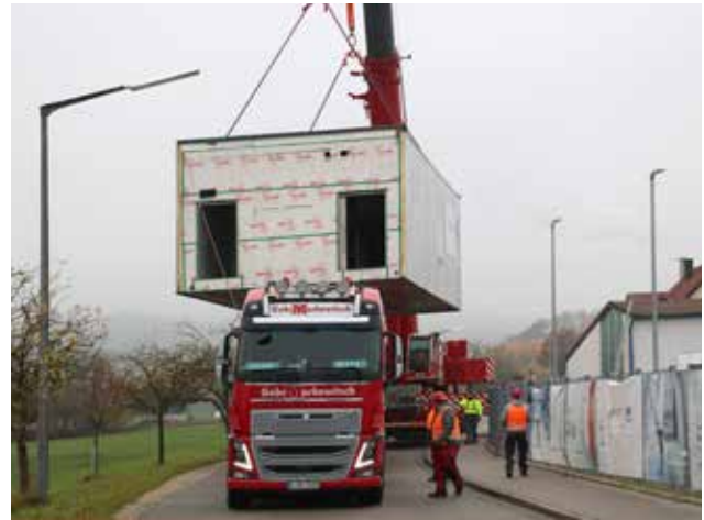
Die Fast-Track-Anlage in Containerkonstruktion ist leicht zu transportieren (Verladen mit einem Kran; Transport mit LKW oder Schiff)
