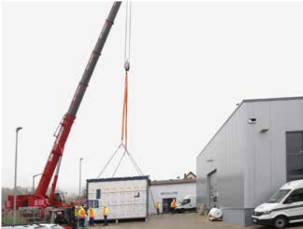
Die Fast-Track-Anlage in Containerkonstruktion ist leicht zu transportieren (Verladen mit einem Kran; Transport mit LKW oder Schiff)
